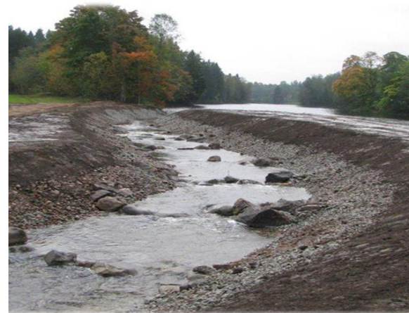
Loobu paisjärve paisule rajatud möödaviik-tüüpi kalapääs
